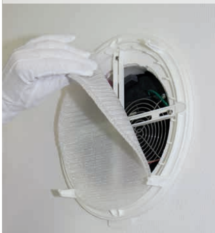
Abnehmen des Staubfilters
