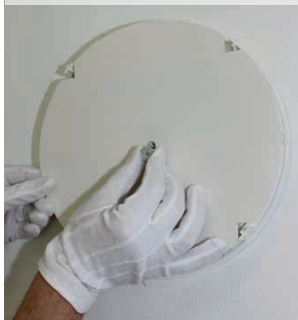
Abschrauben des Schalldämmeinsatzes
